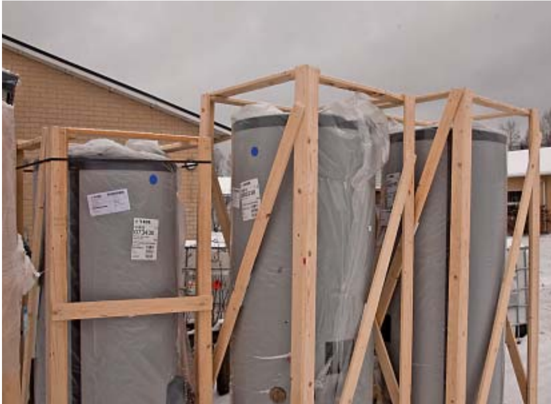
Maalämpö maksaa itsensä takaisin 5-6 vuodessa. Peltokujalla lämpökattilat odottavat asentamista.
