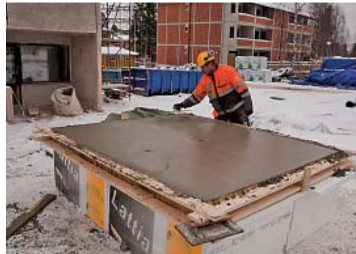
Hissi helpottaa sekä lapsiperheiden että vanhemman väen asumista yläkerroksissa. Kirvesmies Jussi Karjalainen viimeistelee hissinkaton valulaattaa Lohtajan Kaikukadun työmaalla.
