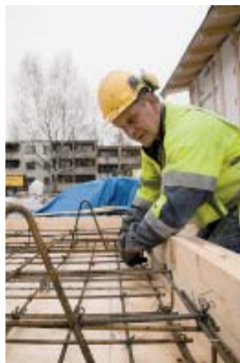
Aimo Teeriniemi raudoittaa hissikuilun katon valurakennetta Erätiellä. Hissi helpottaa sekä ikäihmisten että lapsiperheiden arkea kerrostalossa.
