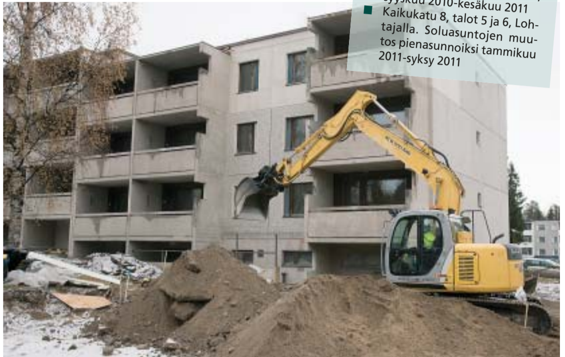
Teppanan Erätie 18 peruskorjaus valmistuu kesäkuun lopussa 2010.
